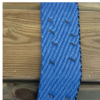
Σύνδεση με μάντα προπυλενίου πάχους 5cm και προστασία UV
