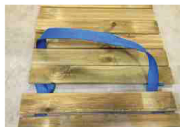
Σύνδεση με μάντα προπυλενίου πάχους 5cm και προστασία UV
